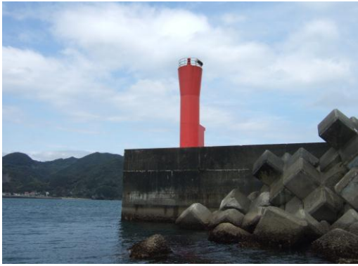
防波堤の外側から子浦方向を望む
