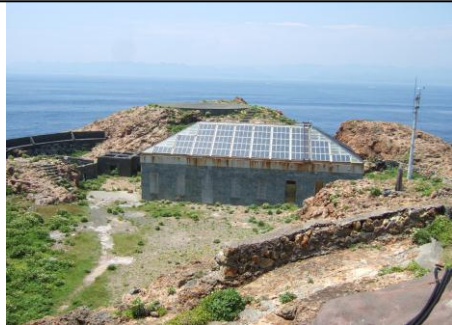
灯台の電気を確保する付属舎太陽光パネル
