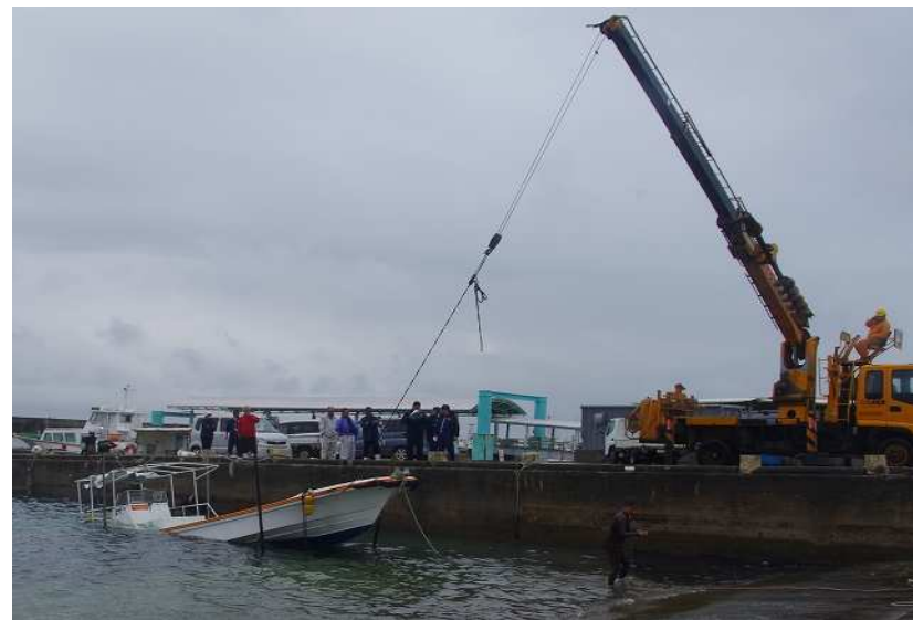
番号 遊漁船(クレーン車により引揚げている状況)
