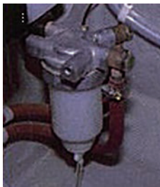
油水分離器 (船体)
