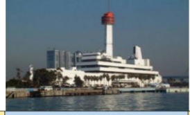
東京海上保安部 港内交通管制室
