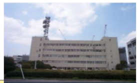
千葉海上保安部 港内交通管制室
