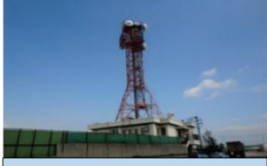
川崎海上保安部 港内交通管制室
