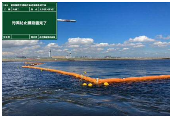
汚濁防止膜設置状況
