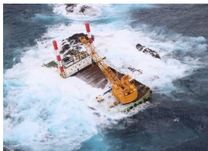
貨物船の船体亀裂
