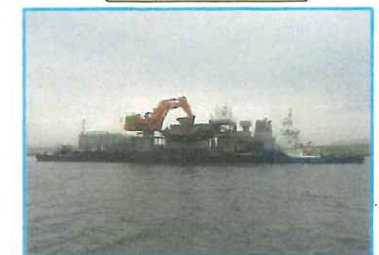
空気圧送船設置
