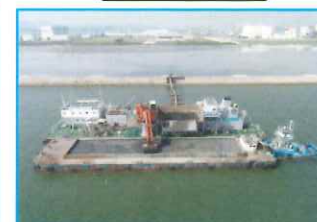
空気圧送揚土工
