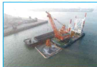
グラブ浚渫工
