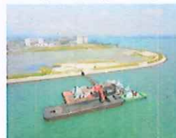
【空気圧送揚土状況】
