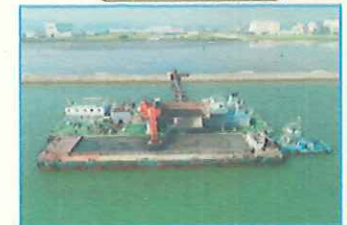
空気圧送揚土工
