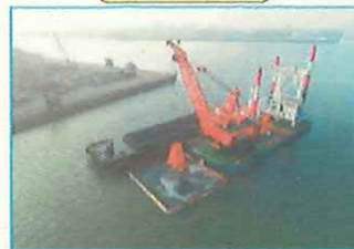
グラブ浚渫工
