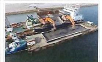
空気圧送揚土工
