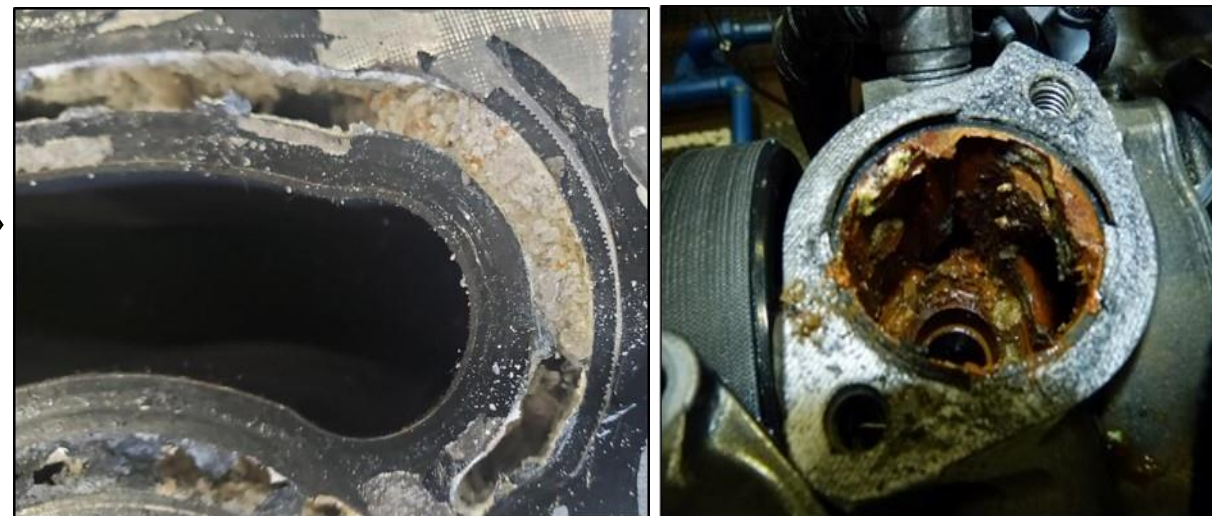
汚れた冷却水通路
